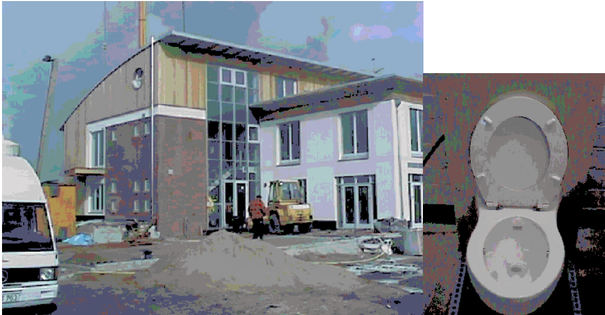
Fig.9.4 (left) Le bâtiment commun dans l'agglomération de Flintenbreite; (right) Un WC – vaccum utilisant un litre d'eau.
